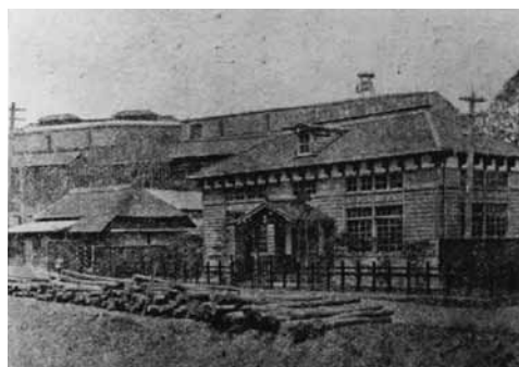
水戸の火力発電所 (『前島平』より転載)
